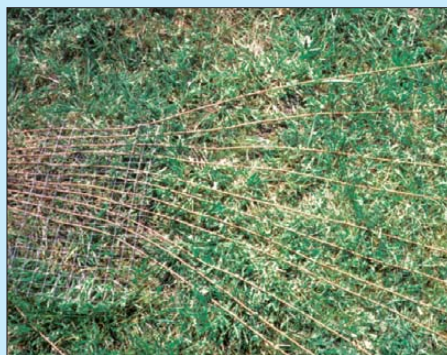
Bild 59: Um die Radials zum Rasenmähen bequem aufnehmen und wieder geordnet verlegen zu können, hat DJ2EV die einzelnen Drähte durch Kaninchengitter gefädelt. Man kann die Radials auch in den Rasen einwachsen lassen – das geht schneller, als man denkt –, man verzichtet damit jedoch auf die Möglichkeit zu vertikalisieren. Fotos: DJ2EV
