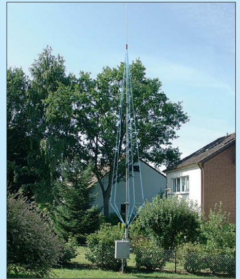
Bild 58: Gesamtansicht der Antenne [49]; die Drähte der Reusenstruktur wurden im Foto zur besseren Erkennbarkeit nachgezeichnet.
